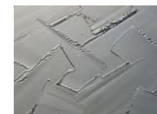
Špachtľovanie s metalickým náterom
