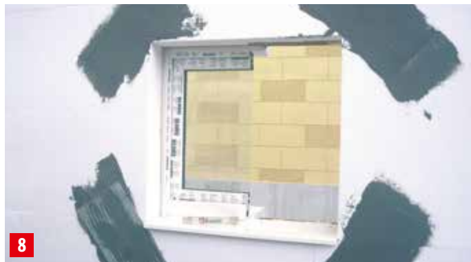
8 Prídavná výstuž v rohoch otvorov sa ukladá do vopred nanesej vrstvy lepidla, povrch sa následne zahladí. Po celoplošnom stierkovaní má byť krycia vrstva lepidla v tomto mieste min. 0,5 mm.
