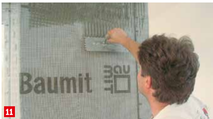
11 Pomocou antikorového hladidla sa mriežka vtlačí do lepiacej stierky a povrch sa dôkladne zahladí.
